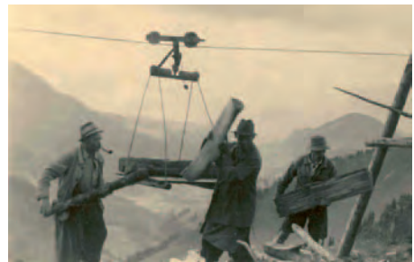
Holztransport mit einem Lastenaufzug zur Hochries
